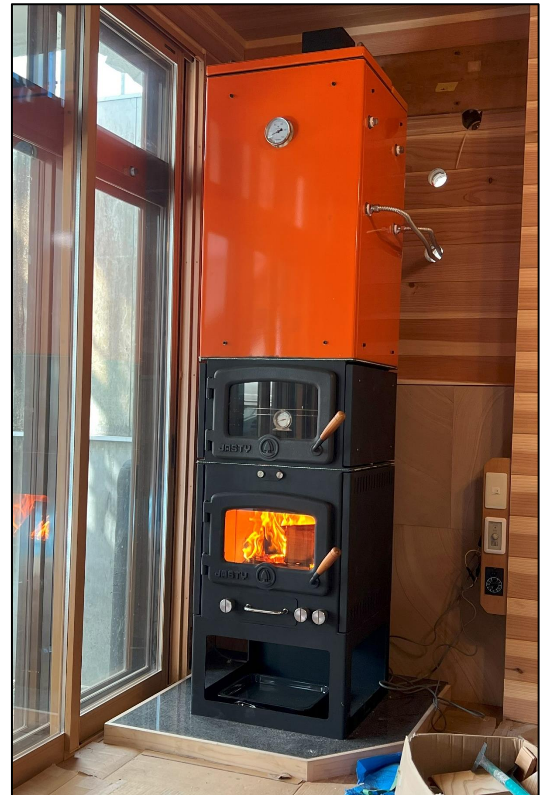
オーブン付薪ボイラー 貯湯量 120L 薪長 35 cm 床暖房と給湯に使用
